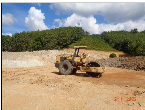
งานบดอัดพื้นดิน เพื่อดำเนินการก่อสร้างอาคารสำนักงานและบ้านพักพนักงาน
