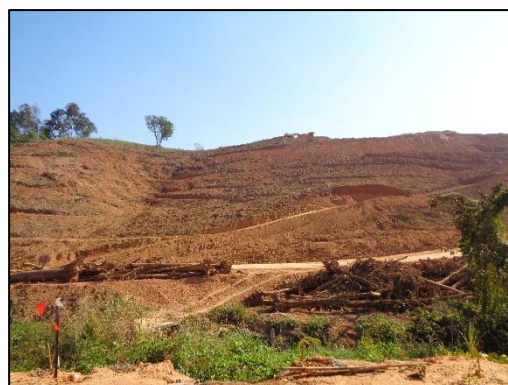
การเตรียมพื้นที่บริเวณเชิงเขาเพื่อทำแนวป้องกันการพังทลายของดิน
