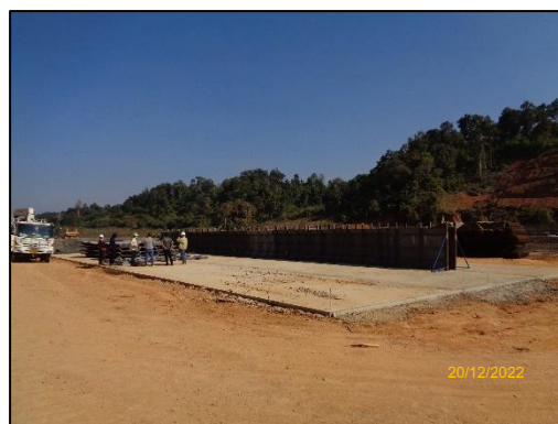
งานผูกเหล็กและหล่อคอนกรีต
