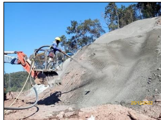
งานผนังกันดินพ่นคอนกรีต (Shotcrete)
