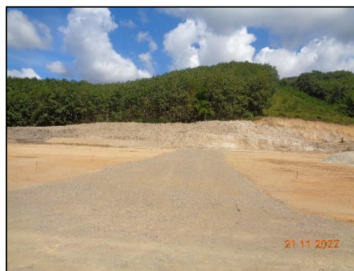
งานบดอัดพื้นดิน เพื่อดำเนินการก่อสร้างอาคารสำนักงานและบ้านพักพนักงาน
