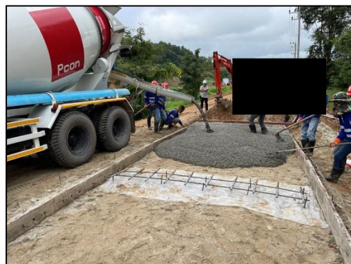
งานก่อสร้างถนนคอนกรีต
