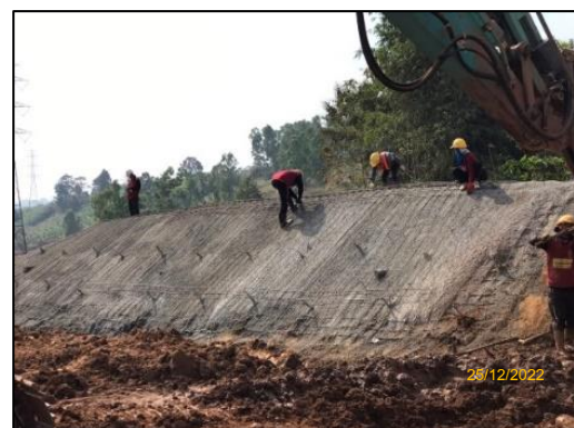
งานติดตั้งตะแกรงเหล็ก Wiremesh
